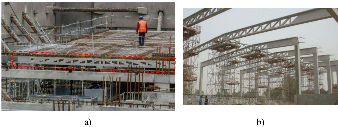
a) Viga de 7,8 m em um estacionamento em Drancy, França , 2022 (MAITENAZ et al. , 2024); b) Construção de pórticos tréliçados de concreto armado protendido (SAMIR; MORCOUS, 2014)
